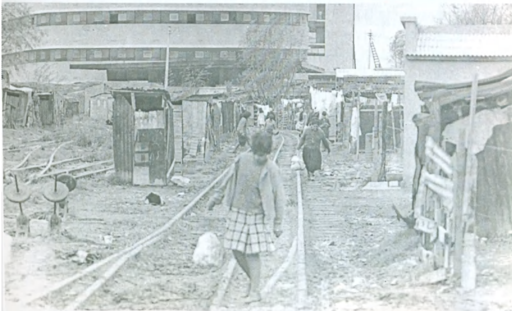
Villa miseria, década del noventa.
