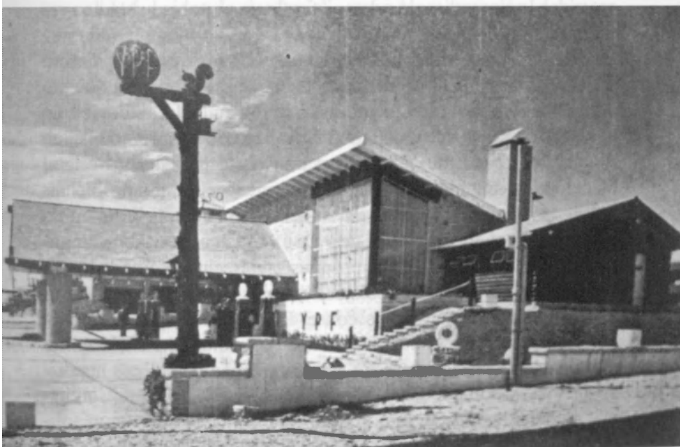
Estación de servicio de YPF en Peralta Ramos, Mar del Plata, Arq. Jorge de la María Prins, 1938.
