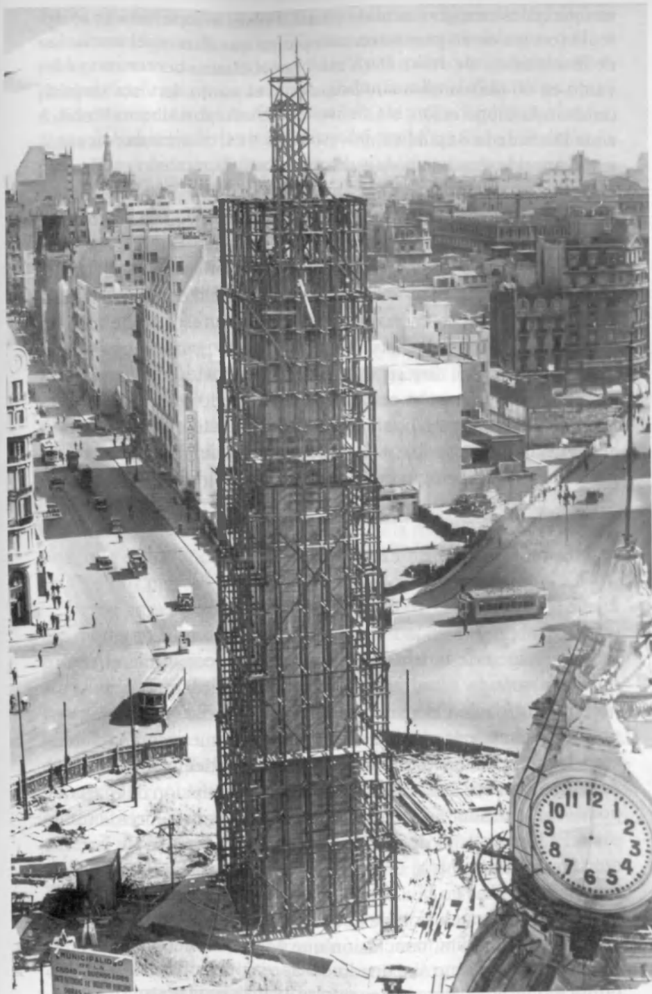
Construcción del Obelisco, 1936.
