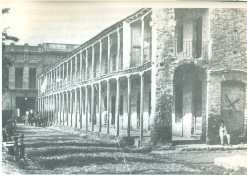
La calle del Pecado, luego llamada Aroma, donde hoy se levanta el Ministerio de Obras Públicas, era una cuadra de prostíbulos, uno al lado del otro, en el barrio de Monserrat.
