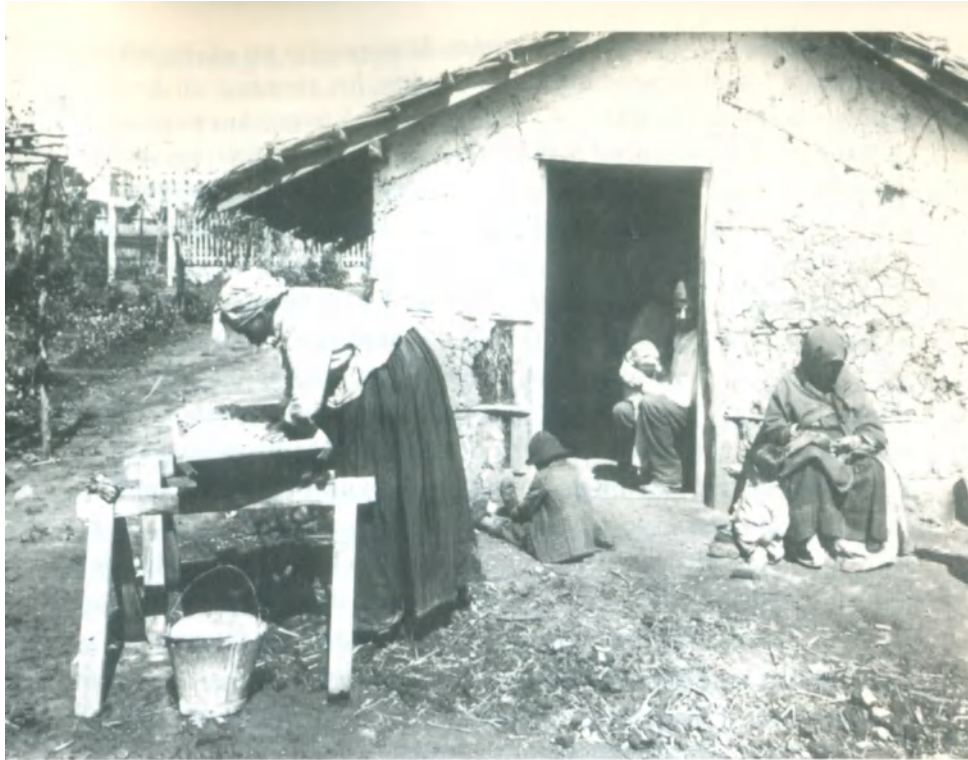
Precarias condiciones de vida y falta de higiene en los ranchos.
