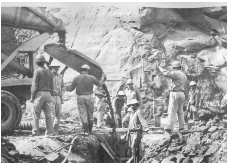
Aspecto de la construcción de la presa de El Chocón-Cerros Colorados, 1972.
