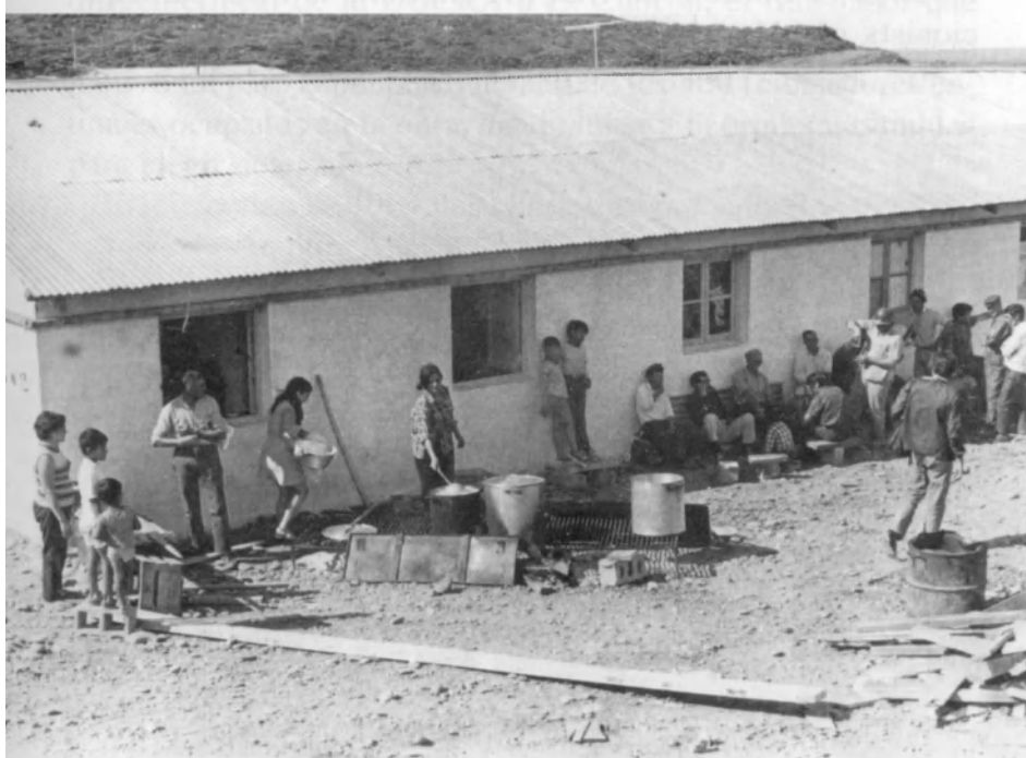
Viviendas de los trabajadores de la construcción de la presa, 1970.
