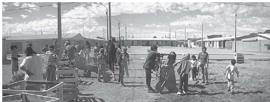
Primeros trabajos de limpieza y nivelación del terreno
