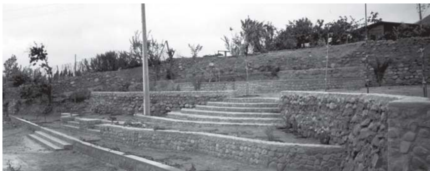
Primera etapa, construcción de muros y escalinatas
